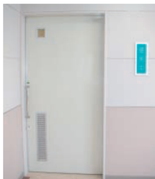
写真: 小窓(カスミアクリル)と長ガラリを組み合わせたスライドドアの仕上がり。
